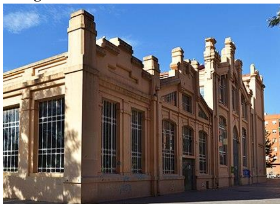
Imagen 7. Central Eléctrica de Nou Moles.
