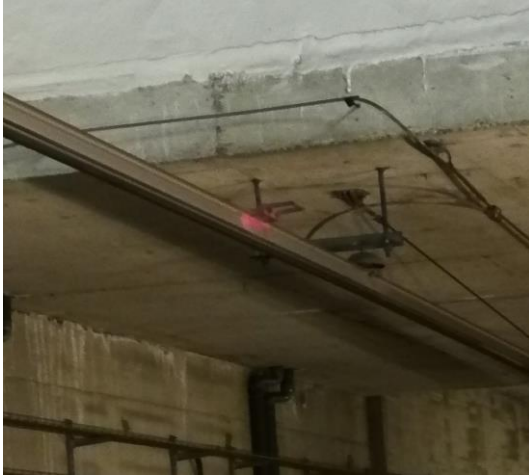
Catenaria rígida con argollas para colocación de pértigas
