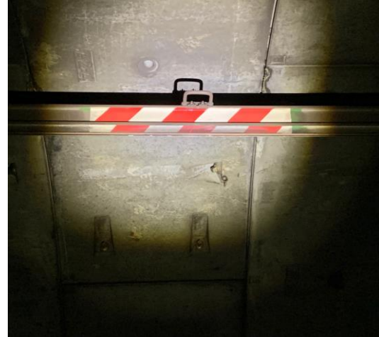
Catenaria rígida con argollas para colocación de pértigas
