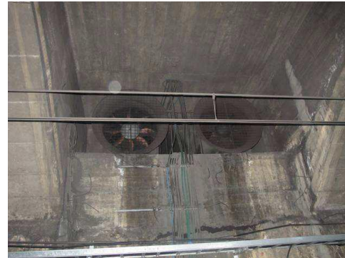
Sistema de ventilación túneles Línea 1-2
