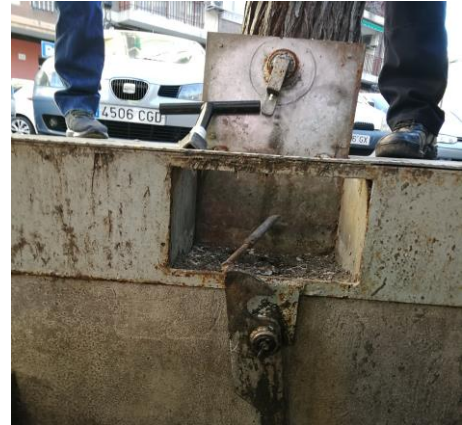
Plataforma de acceso a la Salida de Emergencia y mecanismo de accionamiento
