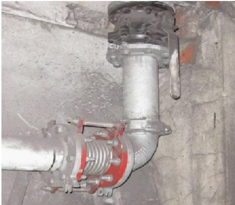
Llaves de seccionamiento columna seca en tramos subterráneos
