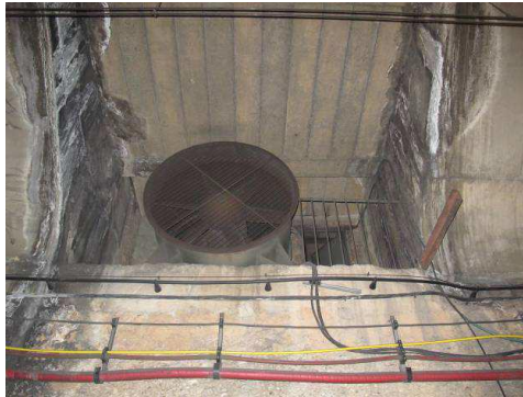
Sistema de ventilación túneles Línea 1-2
